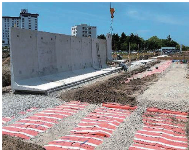
⑨擁壁基礎
