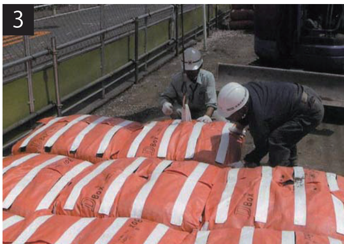
3 重機やクレーンで吊上げ敷設箇所に設置
