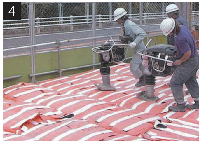
4 敷設が完了したら、ランマーを使い転圧
