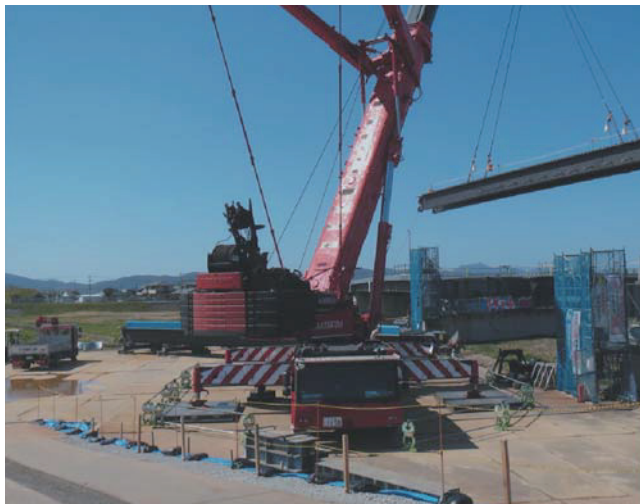
①クレーン布設仮基礎
