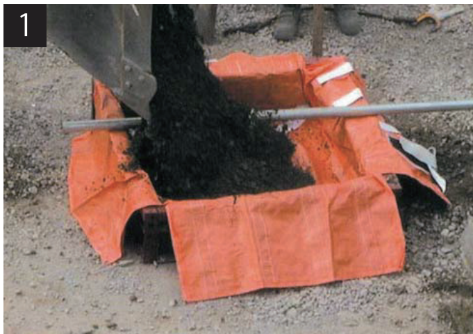
1 D・BOXを専用型枠にセットし、上部より中詰材料を投入
