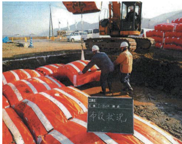
④駐車場基礎
