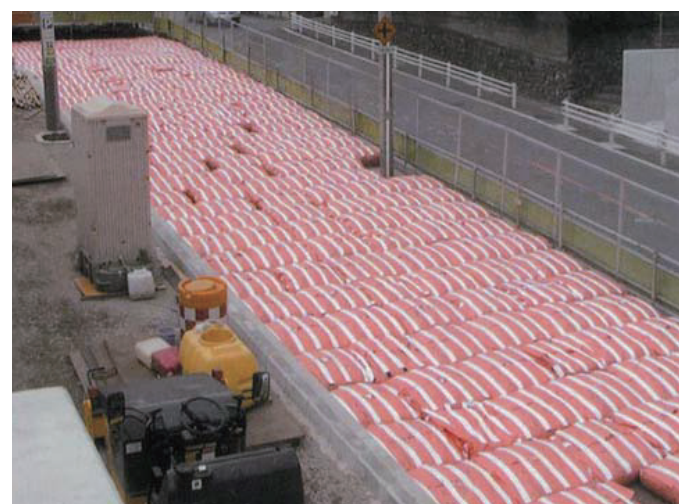
道路の地盤補強及び振動低減の施工例
