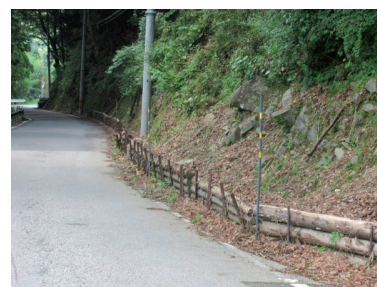
簡易木柵による対処事例
