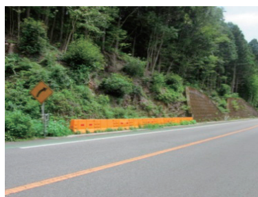
プラスチック防護柵の対処事例
