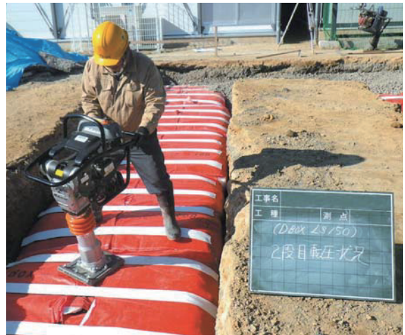
4) 締固め機械で転圧
