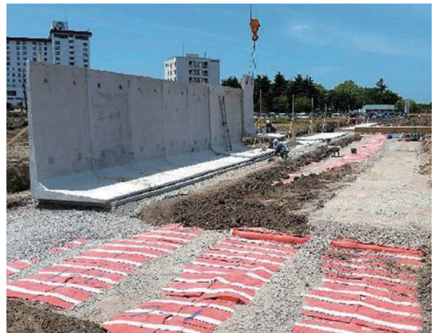
⑨擁壁基礎
