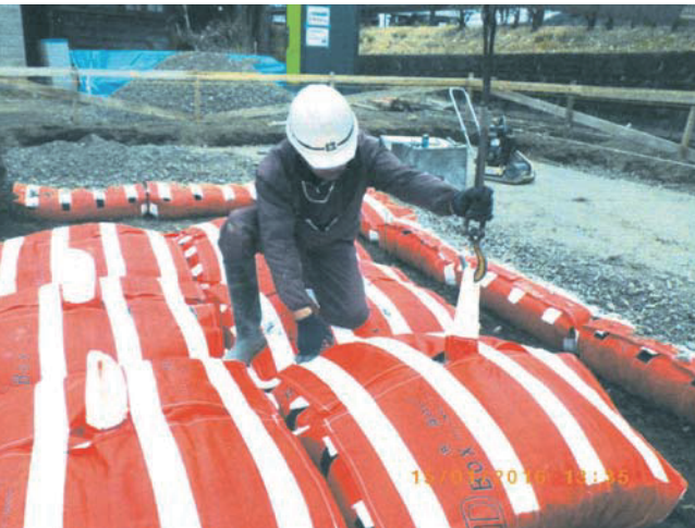
3) 重機やクレーンで吊上げ 敷設箇所に設置
