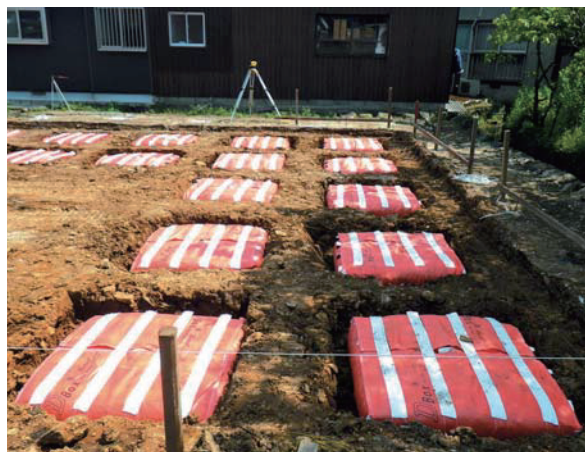
6) 戸建住宅の地盤補強及び 振動低減の施工例
