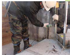
スレートボード位置を決定し、設置後に削孔(設置位置で組み立てた場合)
