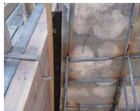
アングル間を鉄筋で結合補強した例
