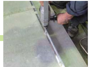
平地で縦バタ用鋼材の位置決めし、スレートボードに削孔(平地で組み立てた場合)
