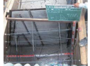
二段以降の設置が完了した状況
