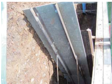
張コンクリート擁壁 その1
