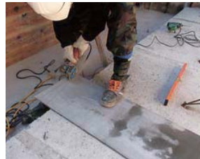
位置寸法に合わせて切断
