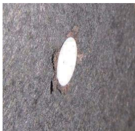
目地材側の設置した状況
