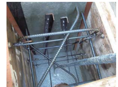
もたれ式擁壁（打設状況）
