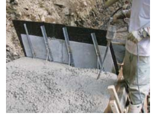
コンクリートの打設状況
