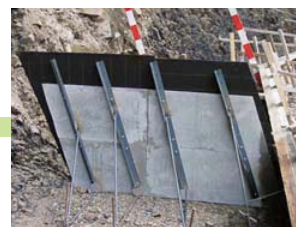
目地材を貼り付けて完了
