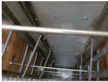
逆T型擁壁
