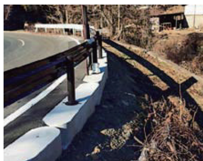
峡東建設事務所（山梨県）
