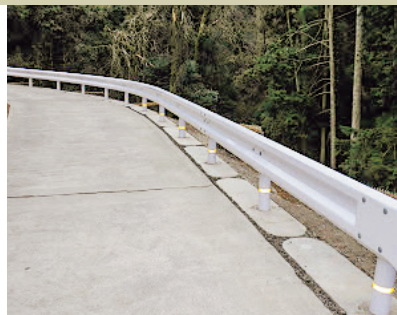
長浜土木事務所(滋賀県)
