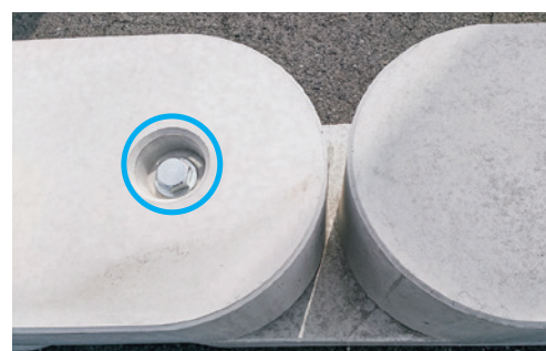
M27 ボルトを使用して連結
