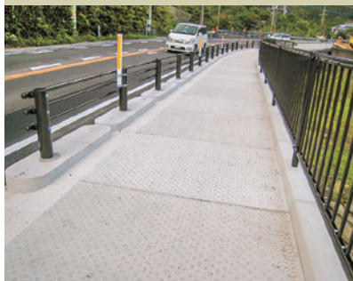
宮崎河川国道事務所(宮崎県)
