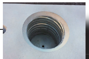
支柱建込穴にはスパイラル鋼管が埋められており 防護柵設置基準・同解説に準拠した支柱建込深250mmに対応
