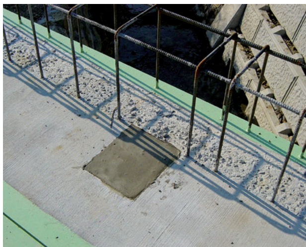
HC床版設置工事 施工状況 T-25 (L) 9448 × (B) 1294 (995) × (t) 380
