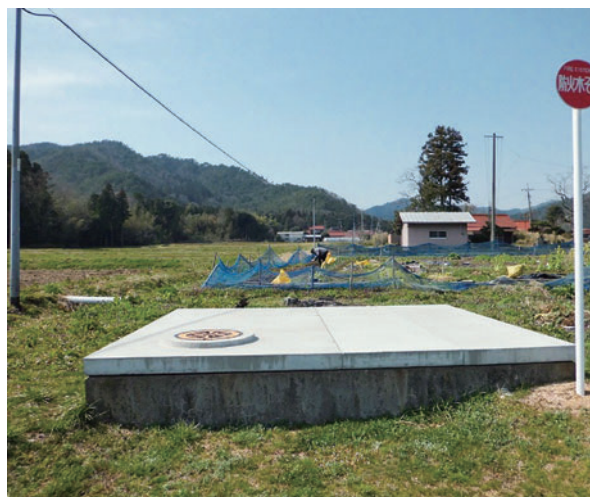
防火水槽ふた設置工事 10kN/m 2 (L) 4500 × (B) 1500 × (t) 150 等
