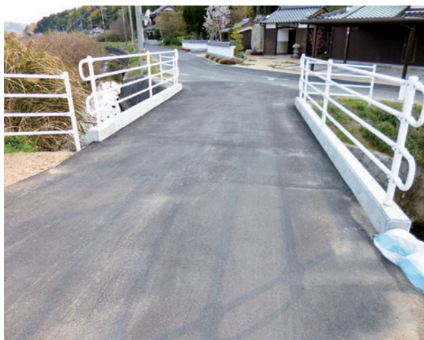
清水橋 橋梁架け替え工事 T-14 (L) 8500 × (B) 1000 × (t) 320
