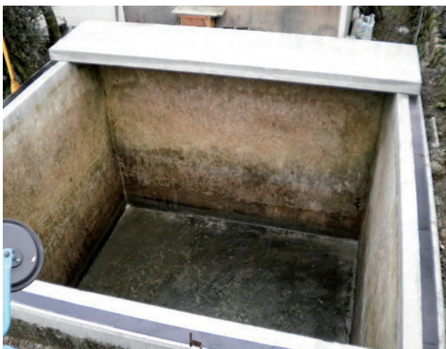
防火水槽ふた設置工事 10kN/m 2 (L) 4500 × (B) 1500 × (t) 150 等
