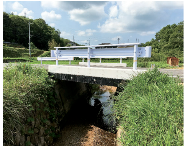
宇部美祿線 立熊橋 橋梁補修工事 T-25 (L) 4960 × (B) 1419 (1229) × (t) 300
