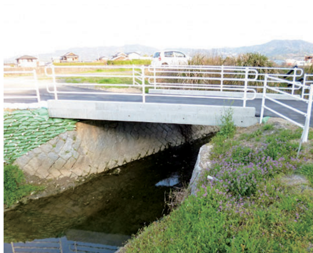
清水橋 橋梁架け替え工事 T-14 (L) 8500 × (B) 1000 × (t) 320
