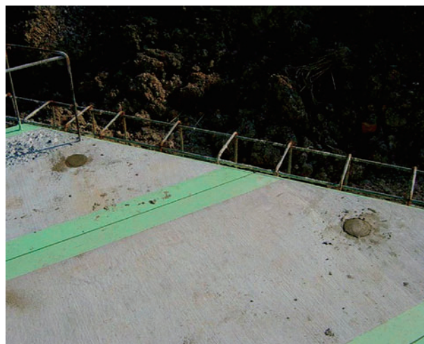
HC床版設置工事 施工状況 T-25 (L) 9448 × (B) 1294 (995) × (t) 380
