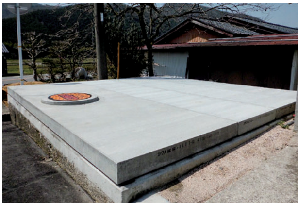
防火水槽ふた設置工事 10kN/m 2 (L) 3500 × (B) 2000 × (t) 130 等
