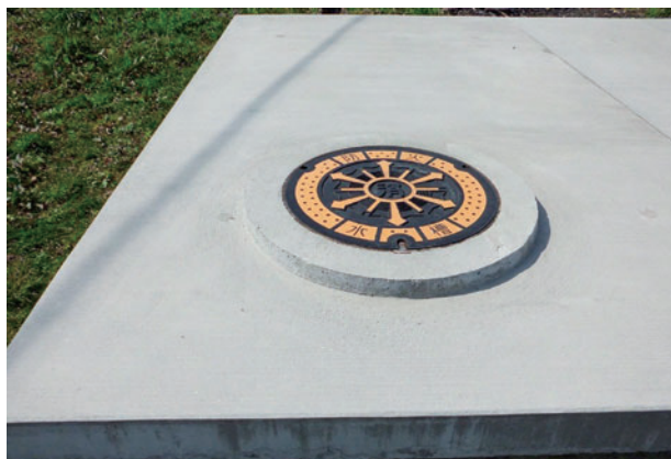
防火水槽ふた設置工事 10kN/m 2 (L) 3500 × (B) 2000 × (t) 130 等
