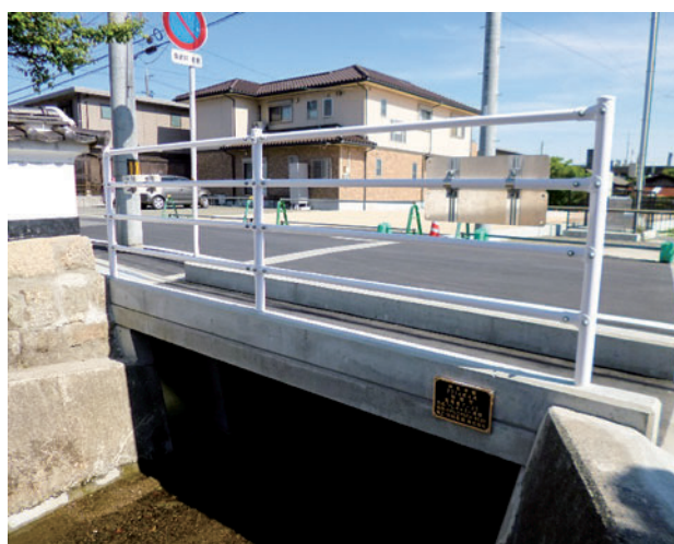
市道川崎・平野線(浄真寺橋) 改修工事 T-25 (L) 4600 × (B) 1006 (996) × (t) 280
