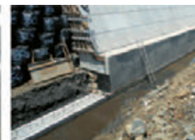
5段目までの施工状況
