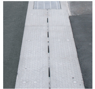
④施工完成
