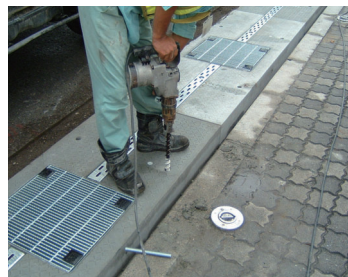
⑪アンカー筋削孔・固定
