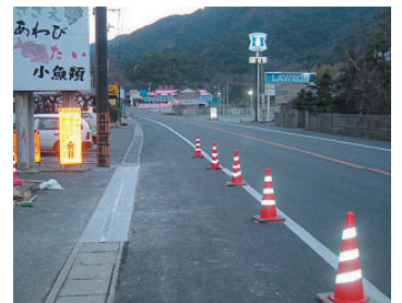
⑫施工完了
