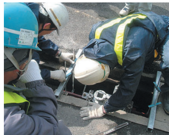
③専用治具によるレールセット
