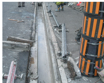
⑦レール取り外し・切断部撤去
