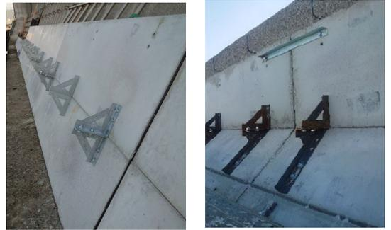
専用固定治具で上下パネルを固定した状態
