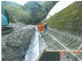
2段目コンクリート打設状況
