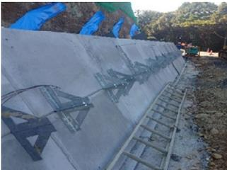
1段目と2段目パネル設置完了
