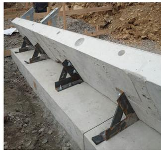
専用基礎版に埋設金具を設置
