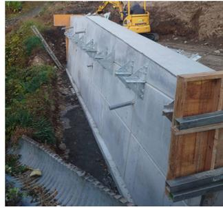
重力式擁壁を天端まで施工完了
