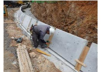
1段目の現場打ち部分の型枠設置
