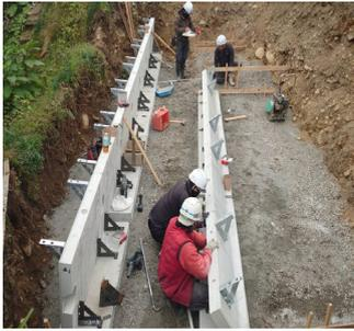
重力式擁壁の1段目パネル設置
