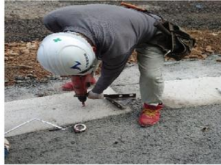
埋設金具の設置用アンカー孔
